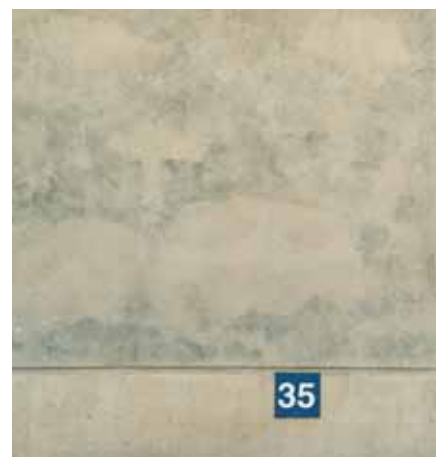
Lasure CONCRETAL faiblement diluée.
